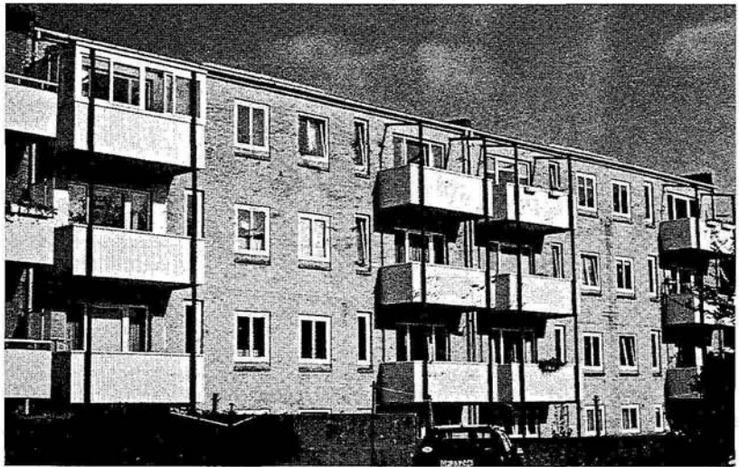
Foto 2: vom Blockinneren, vor der Sanierung
