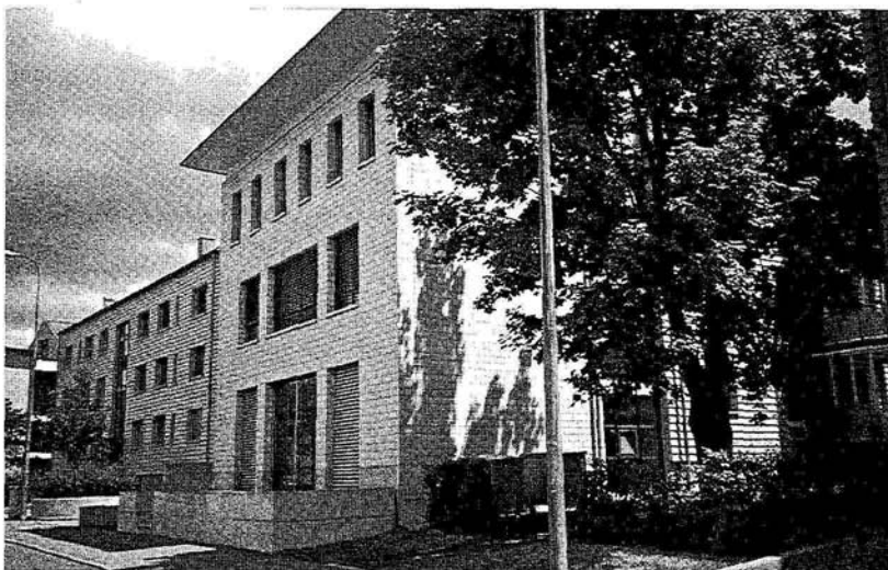
Foto 6: Kopfbauten mit Gemeinschaftseinrichtungen und Kleingewerbeflächen
