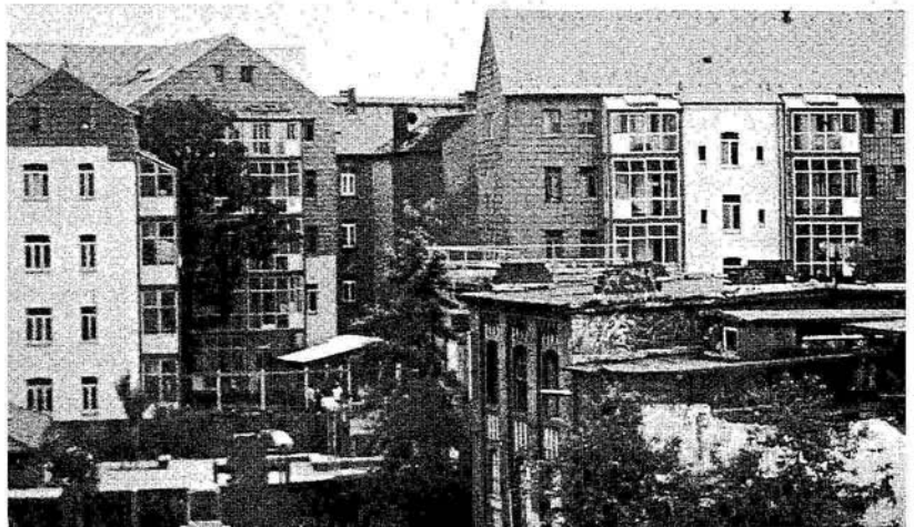
Foto 1: Grundstück Rehbockstraße nach der Sanierung, Hofansicht
