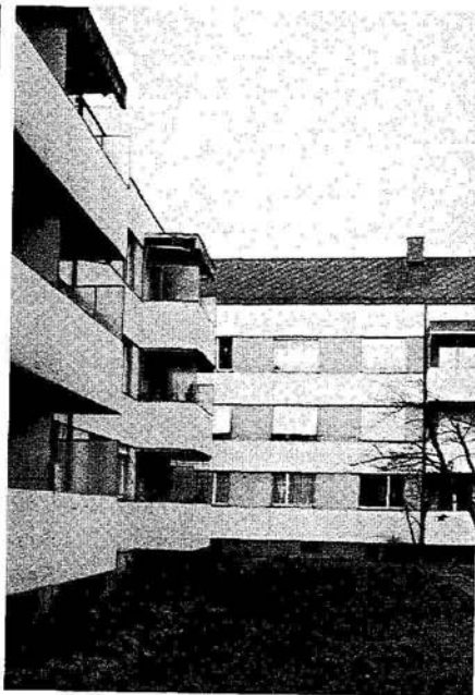
Foto 1 und 2: Siedlung Aarepark vor der Sanierung
