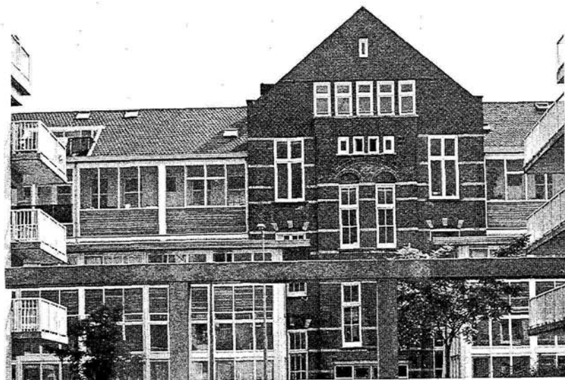
Foto 11 und 12: Westfassade Paviljoen 2 nach der Sanierung
