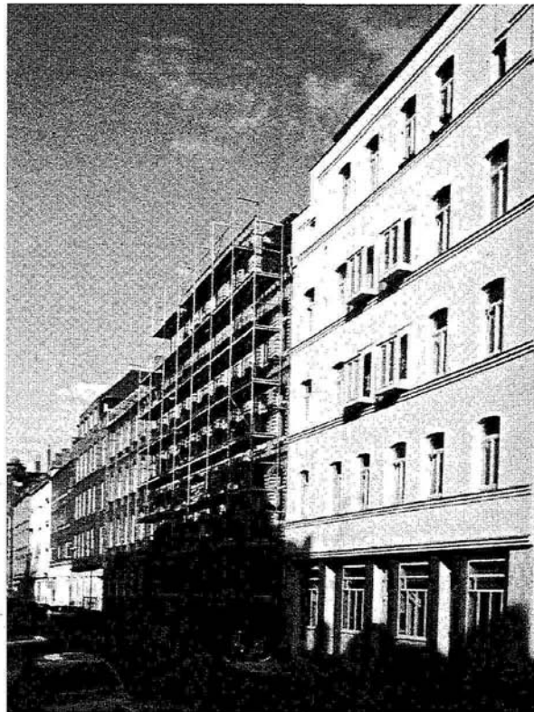
Foto 6: Straßenfassade während der Sanierung
