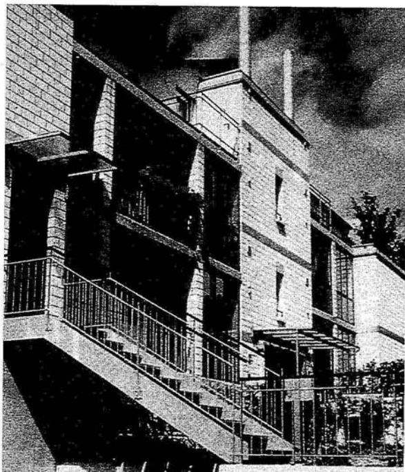
Foto 6: Zugang zu den Wohnungen im Längshaus
